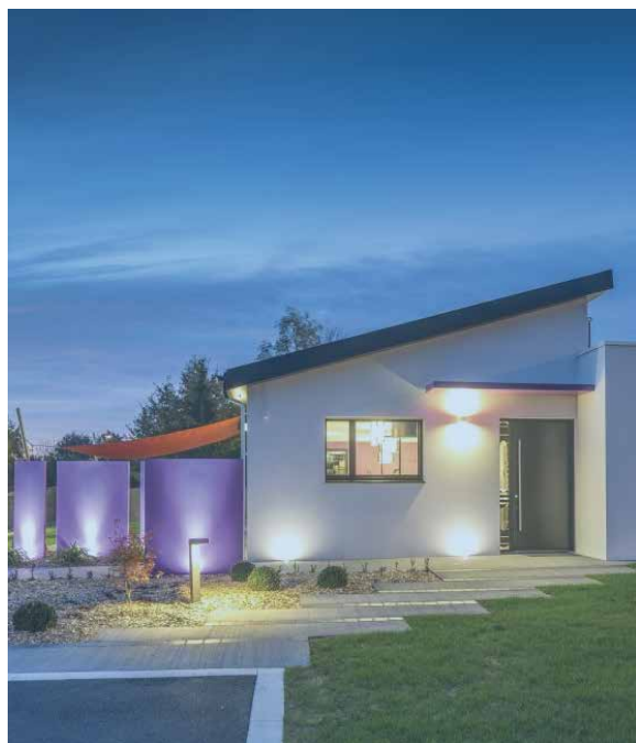
Bepos Effinergie 2013 | La Ferrière (65) | Constructeur : La Bocaine
